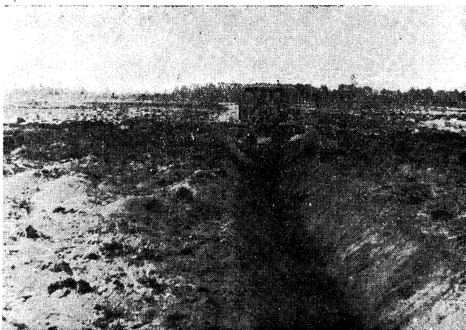
Рис. 2. Фрезерный навесной канавокопатель КФН-1200 в работе Глубина канавы 1,2 м, откосы одинарные (фото автора)
