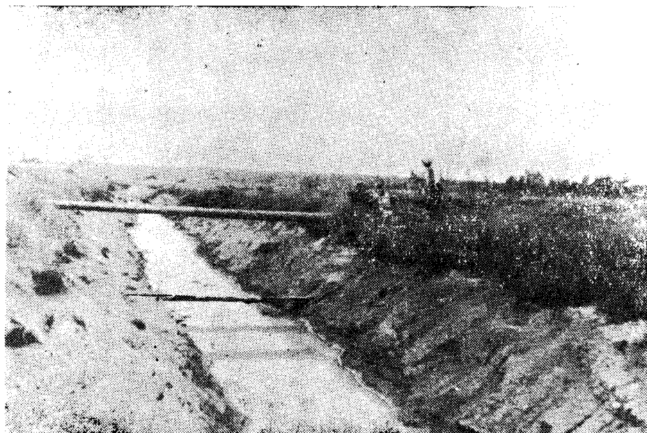
Рис. 1. Второй магистральный канал, выполненный ковшом «Драглайн» (фото автора)
