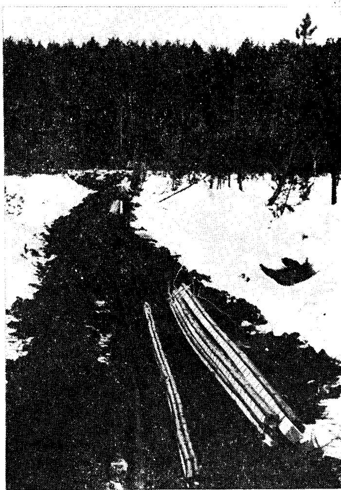
Рис. 4. Подготовка к размещению лепточного заряда взрывчатого вещества в щели торфяника.
