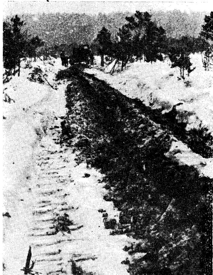
Рис. 2. Щель в торфянике, прорезания установкой «Мороз».
