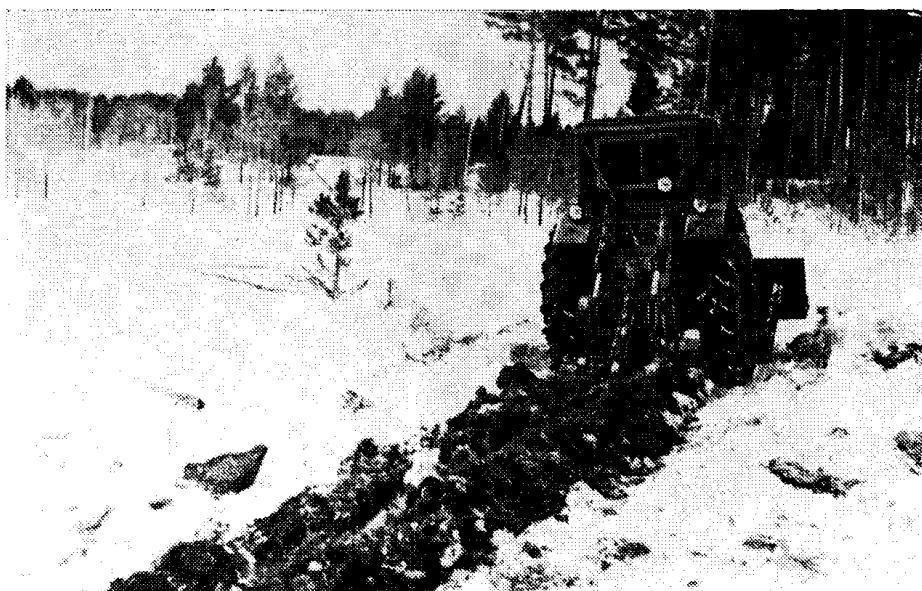
Рис. 3. Землерезная установка БЭТН прорезает щель на болоте.
