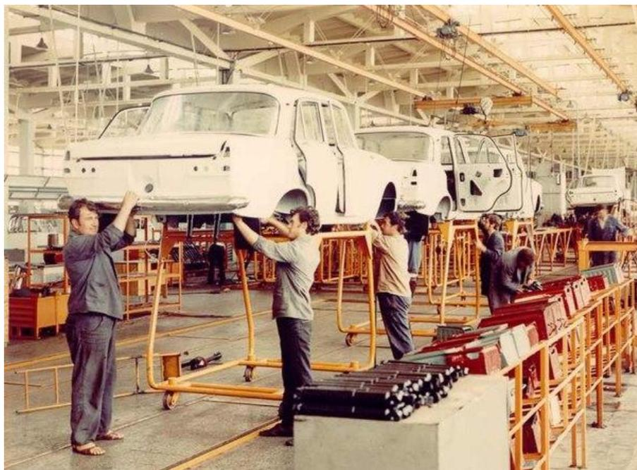
Рис. 1. Конвейер на заводе АЗЛК
