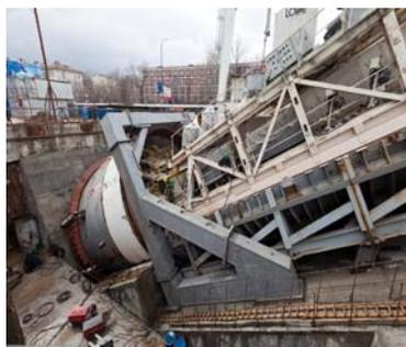
Рис. 2. Рамная конструкция многоразового стартового упора на железобетонном фундаменте
