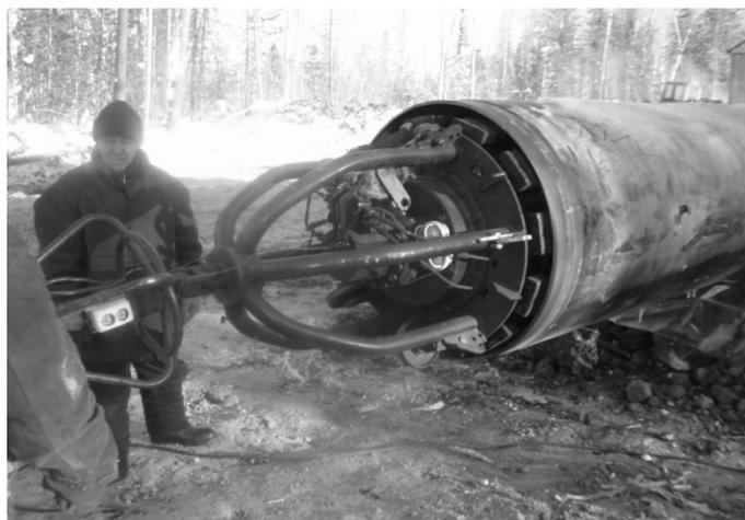
Рис. 1. Установка в трубу внутреннего гидравлического центратора
