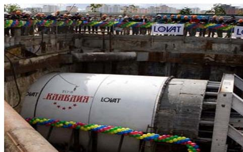
Рис. 3. Отталкивание щита домкратной станцией
