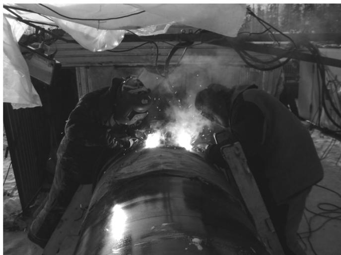
Рис. 2. Техника выполнения швов при сварке магистрального нефтепровода
