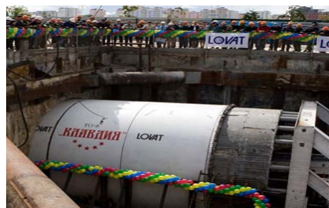
Рис. 3. Отталкивание щита домкратной станцией
