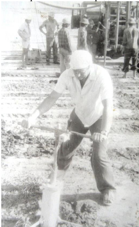
Сердюков В.М. за испытанием грунтов «крыльчаткой»
