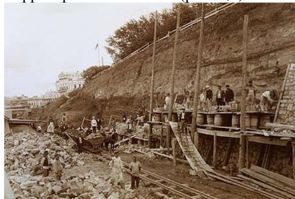
Рис. 3. Строительство подпорной стенки 1885 г.
