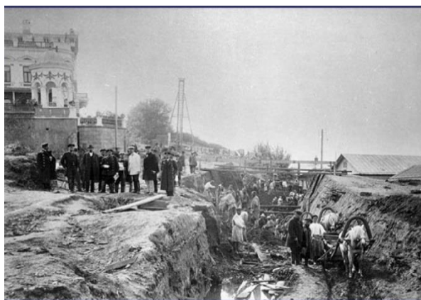
Рис. 1. Выемка под путепровод
