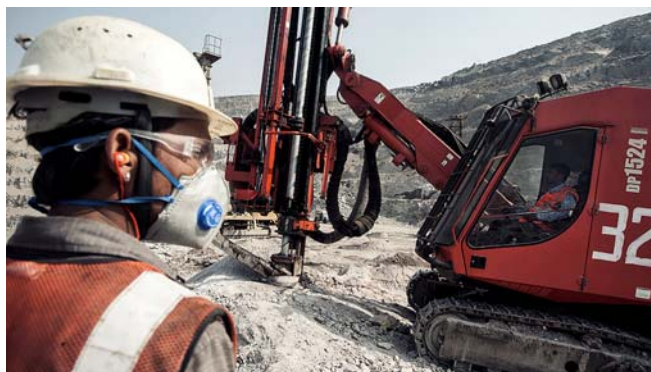
Рис1-1. Пример забуривания дополнительных скважин по периметру взрываемого блока
