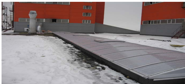
Рис. 1. Фонари, смонтированные в Юрге на заводе ООО «Завод ТехноНИКОЛЬ-Сибирь»
