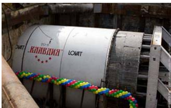
Рис. 2. Отталкивание щита дократной станцией
