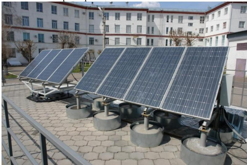
Рис. 1. Конструкция двухсторонней солнечной электростанции
