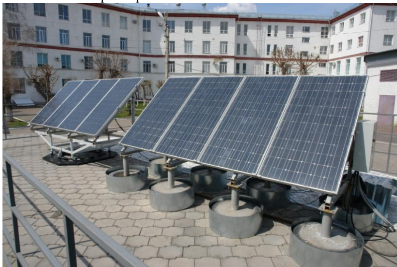
Рис. 1. Конструкция двухсторонней солнечной электростанции
