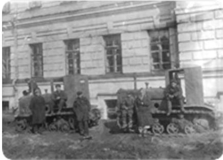
Во дворе Главного корпуса ТИИ, подготовка к посевной
