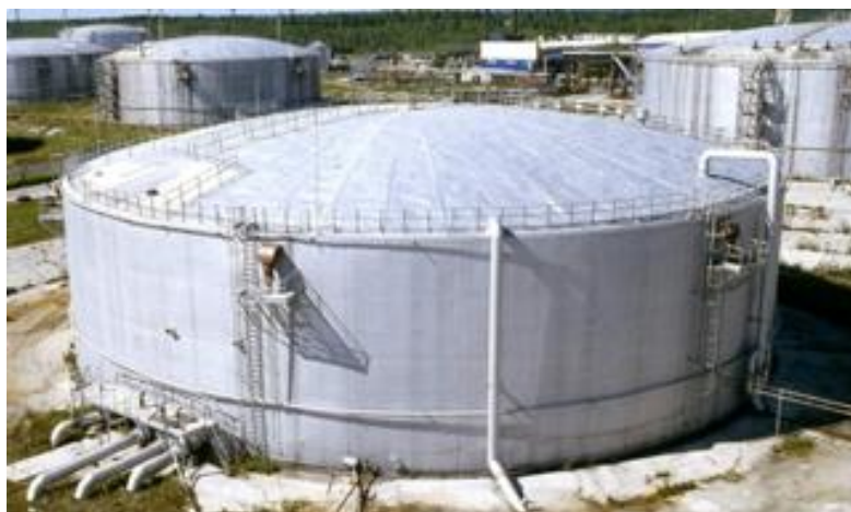
Рисунок 2.1 – Общий вид резервуара вертикального стального типа РВС – 20 000 м 3 [56]
