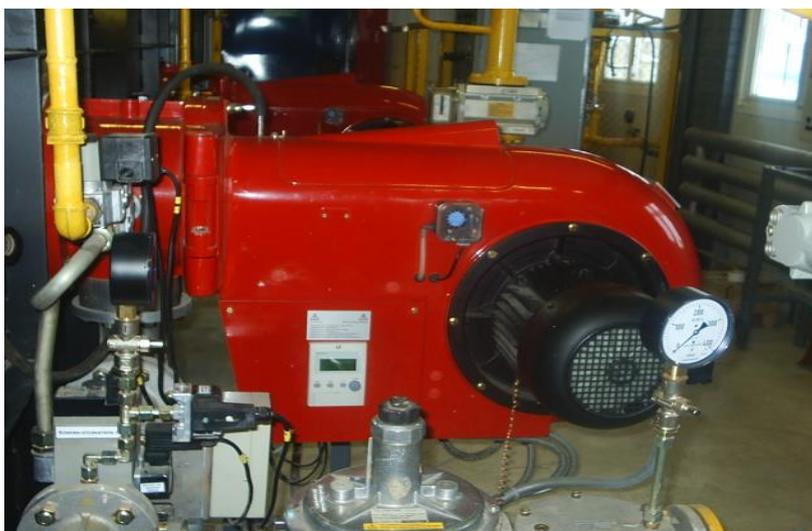
Рисунок 1 – Горелка фирмы Weishaupt
