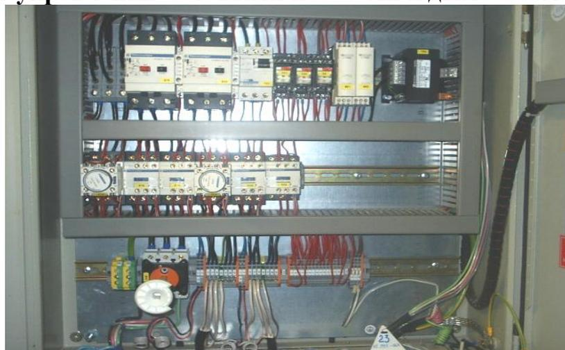
Рисунок 6 – Щит управления насосами и дымососом
