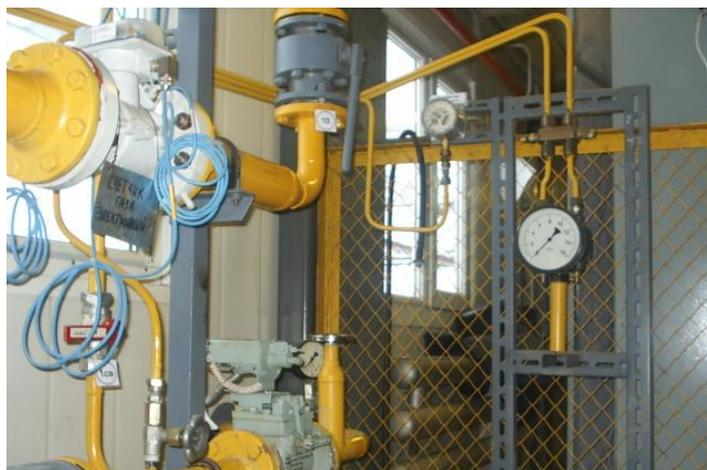
Рисунок 5 – Газовый распределительный узел
