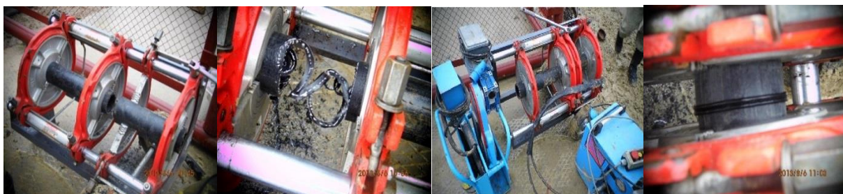
Рисунок 4.12. Сварка полиэтиленовой трубы «Anasconda».
