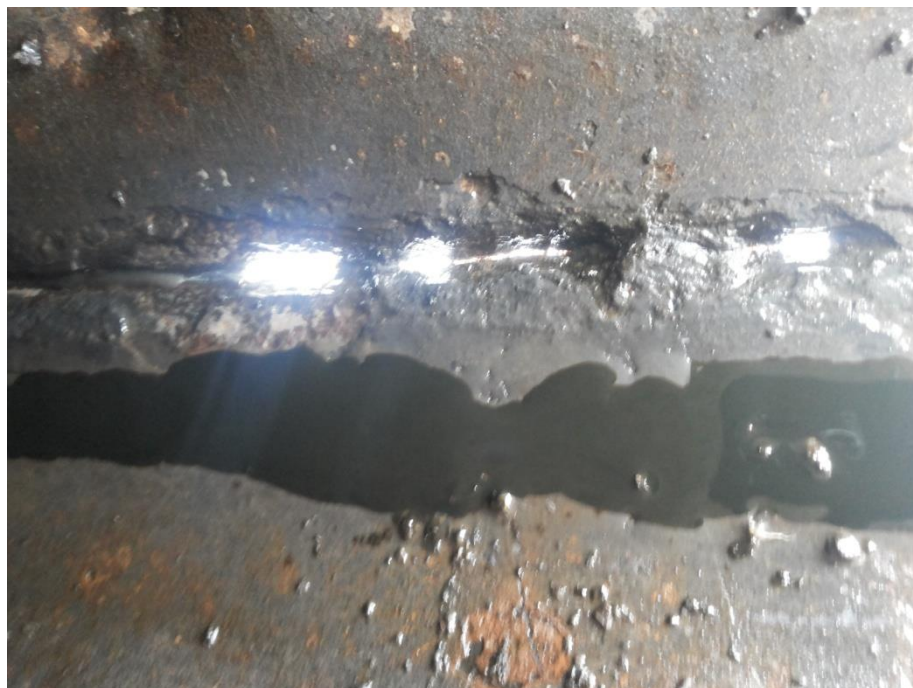
Рисунок 3.1. Коррозия металла на [REDACTED] месторождении, г. Томск, Россия
