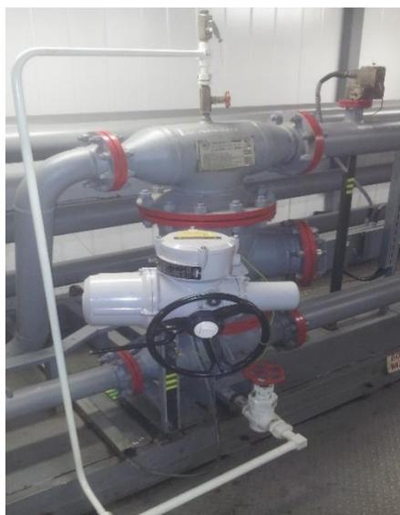
Рисунок 10 - Трубопоршневая установка
