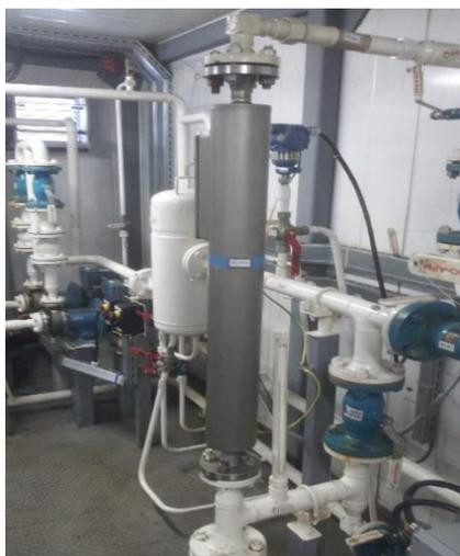
Рисунок 6 - Плотномер
