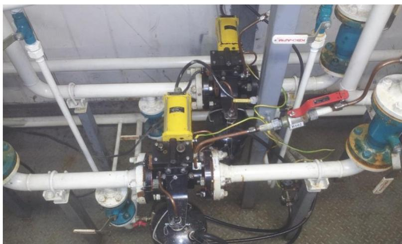
Рисунок 12 - Автоматический пробоотборник
