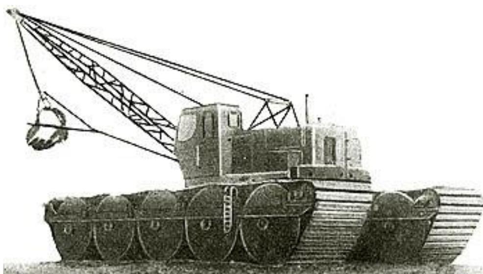
**Рис. 5.** Экскаватор на понтонно-гусеничном ходу модели ЭПГ-1
