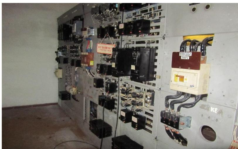
Рисунок 1.3 - Электрощитовой зал насосной станции
