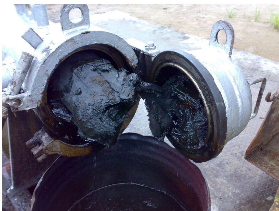
Рисунок 4.16 - Вскрытие камеры приема очистного устройства
