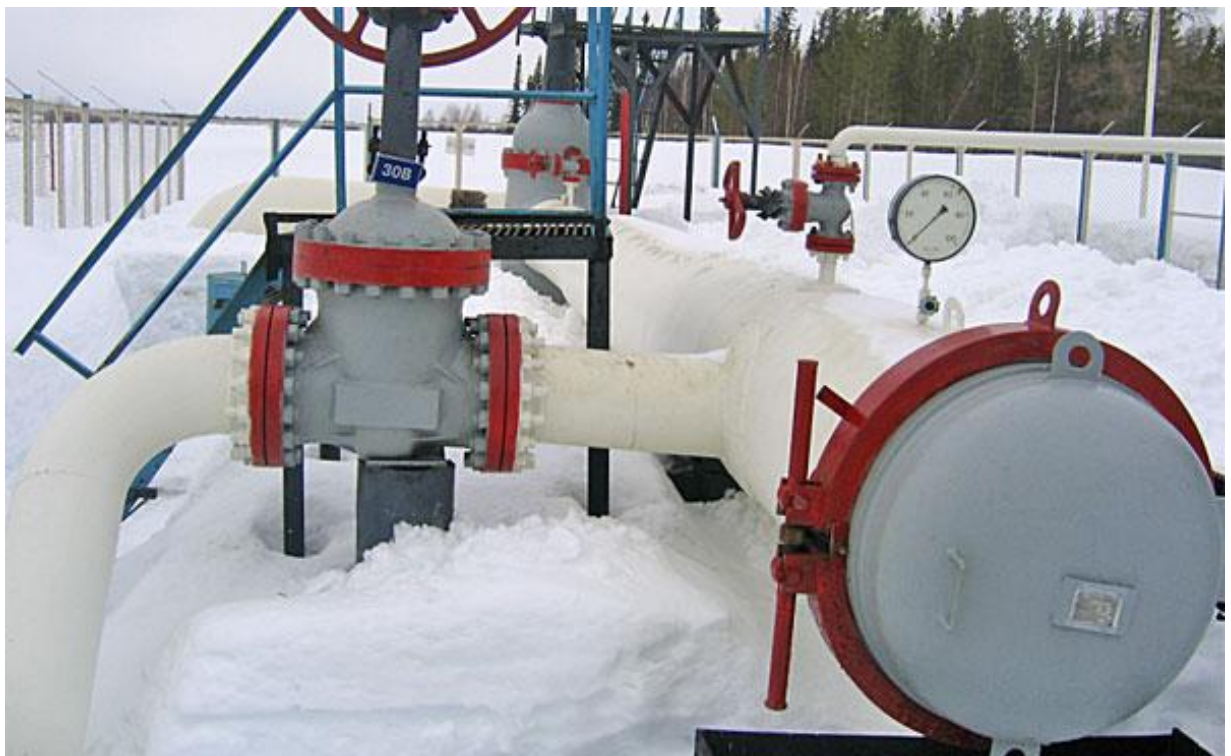
Рисунок 4.14 – Камера запуска очистного устройства
