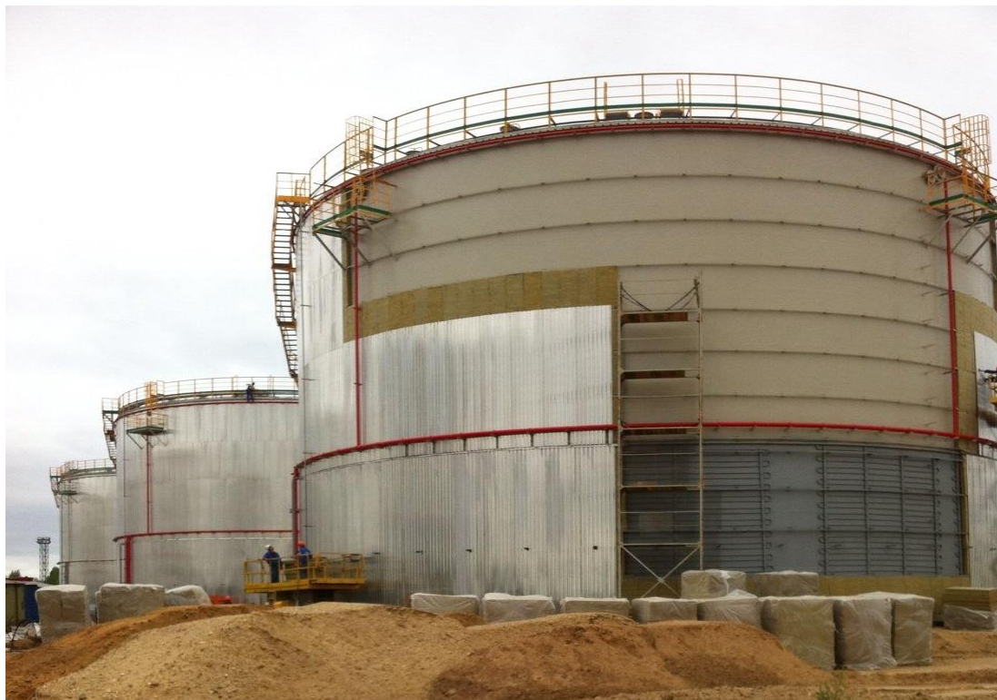
Рис. 21 -Теплоизоляция резервуара
