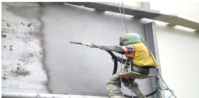
Рис.20- Антикоррозионная защита резервуара
