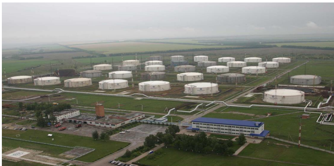
Рис . 10- Самый крупный резервуарный парк в «Транснефть»
