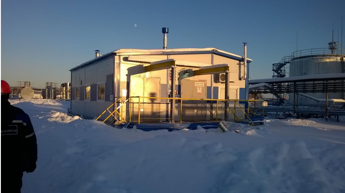
Рисунок 1.1 - Здание блочной кустовой насосной станции
