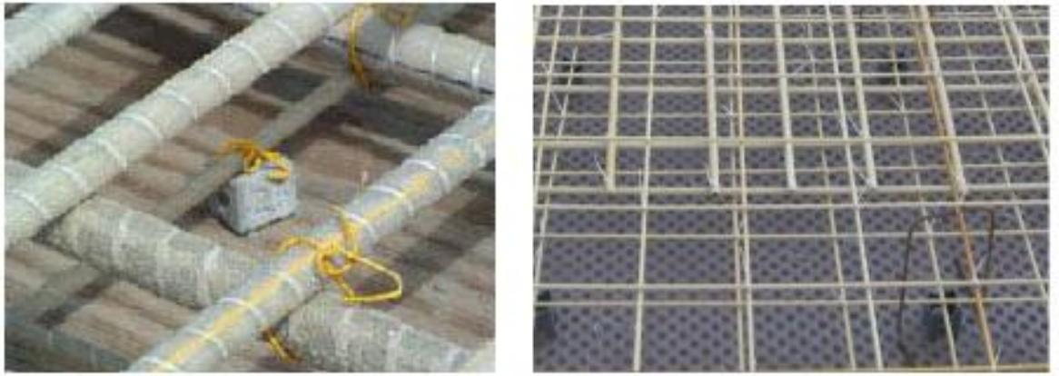
Рисунок 3 – Примеры соединения стеклопластиковой арматуры
