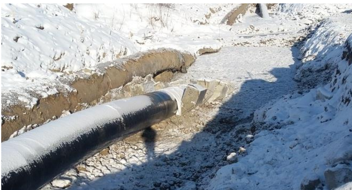
Рисунок 10. - Балластировка трубопровода бетонными утяжелителями типа УБО
