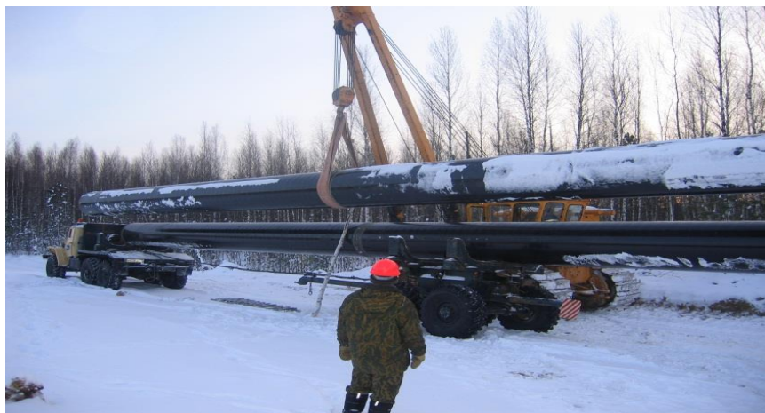
Рисунок 4.- Выгрузка труб на трассе трубоукладчиком «Kamatsu-D355C».
