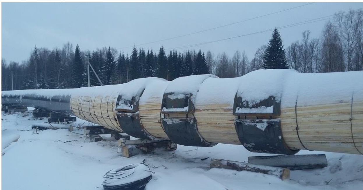
Рисунок 12 - Балластировка трубопровода утяжелителями типа ЧБУ.
