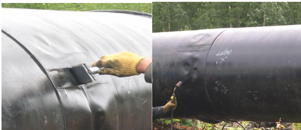
Рисунок 6- Изоляция сварных стыков
