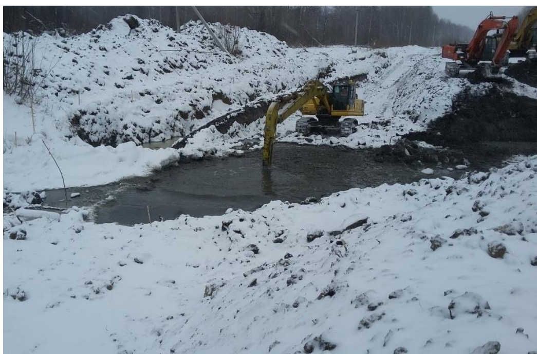
Рисунок 2 - Разработка траншеи в русловой части.
