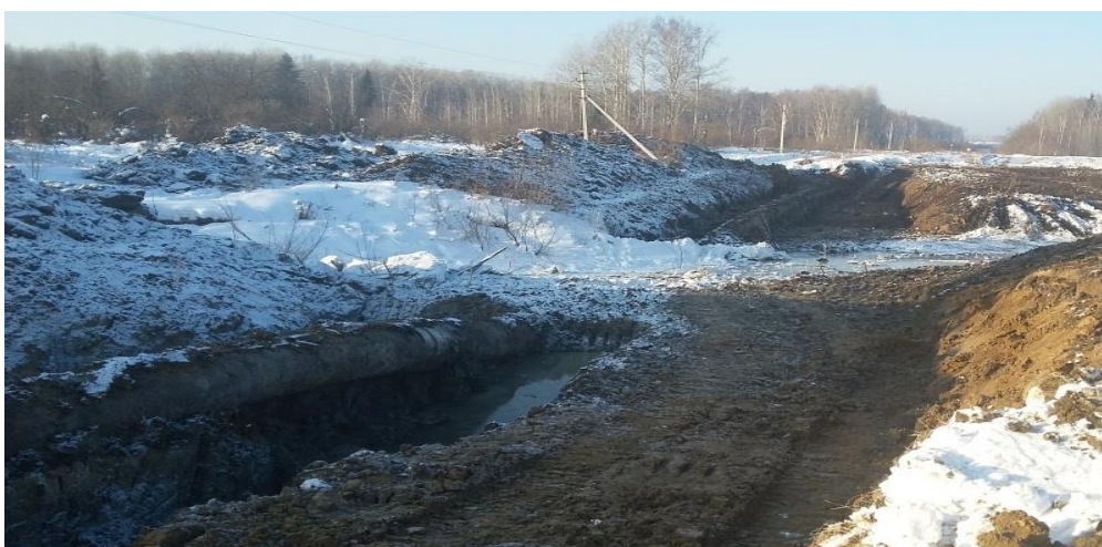
Рисунок 1 - Вскрытие нефтепровода и разработка траншеи
