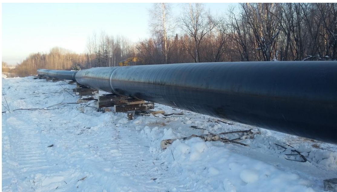
Рисунок 5.- Сварочно-монтажные работы.
