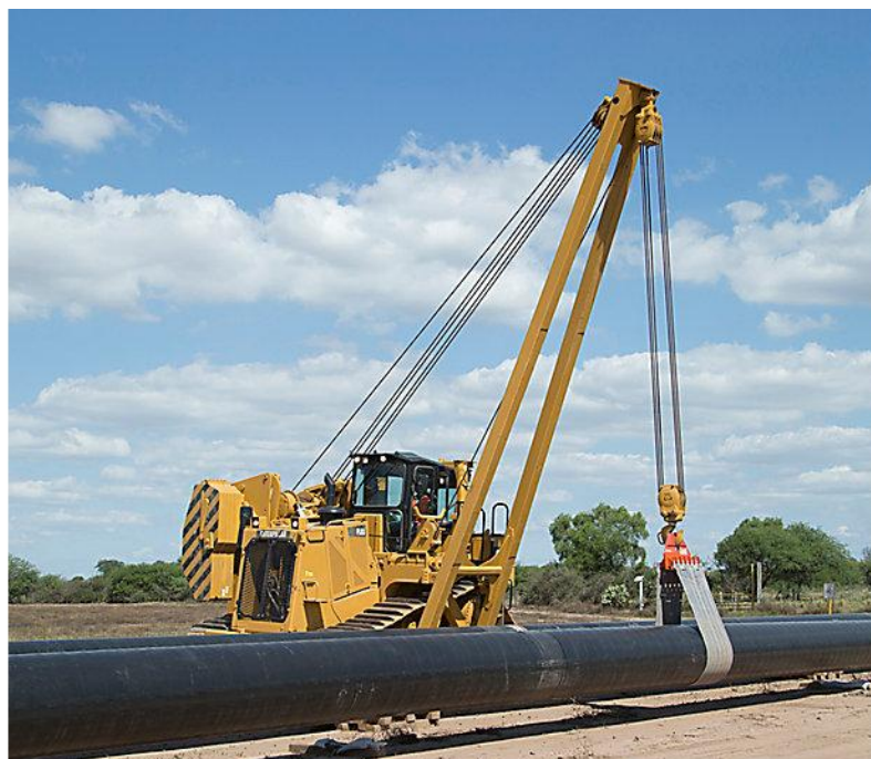
Рисунок 15 – Трубоукладчик Cat PL83
