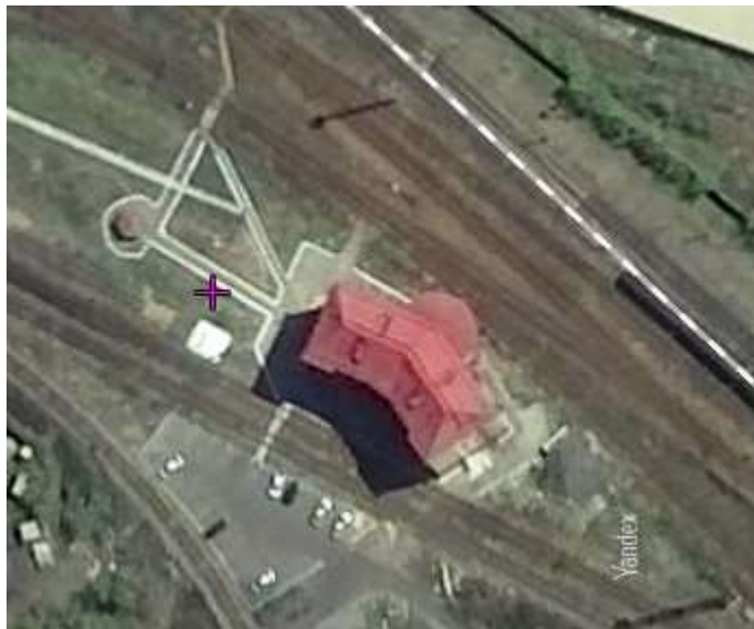
Рисунок 4.1. – Вид здания поста ЭЦ сверху
