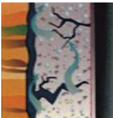
Рис. 5 Высокая объёмная усадка цементного раствора
