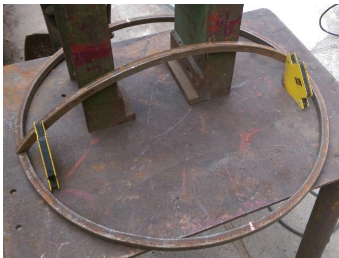
Рисунок 20. Приваривание первой поперечины каркаса
