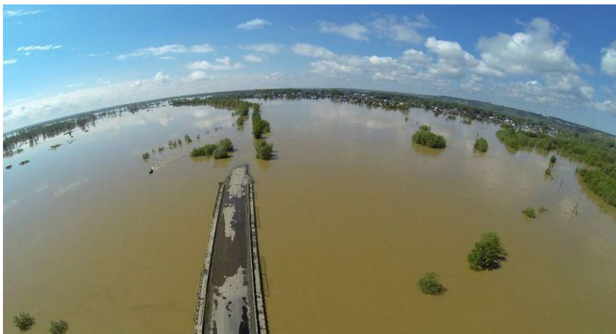
Рис. 1.5. Затопленная дорога в пойме р. Оби. Пос. Затон г. Барнаула [69].
