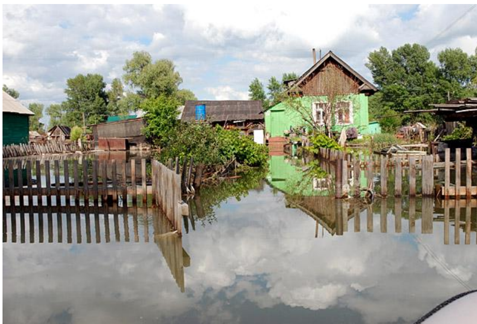
Рис. 1.10. Наводнение (затопление) частного сектора г. Барнаула [69].
