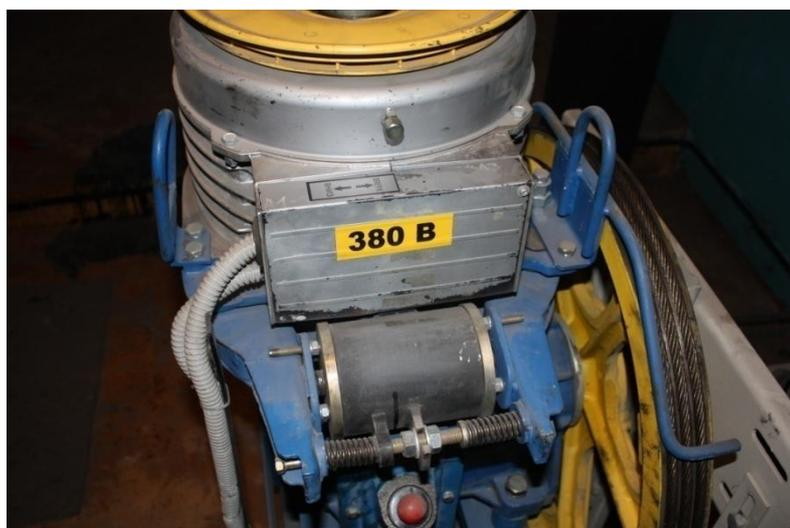
Рис.20 Электромагнитное тормозное устройство
