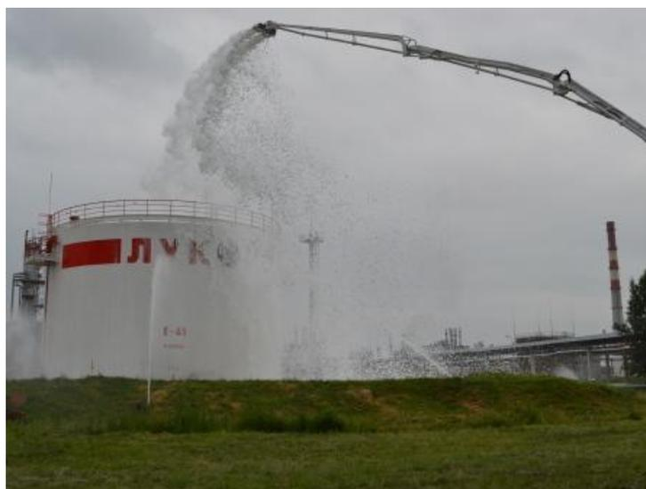
Рисунок 9 – Пеноподъемники пожаротушения типа «Пурга»,
