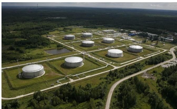
Рисунок 14 – Типовой резервуарный парк с наличием РВС-20000
