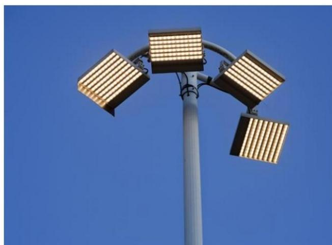
Рисунок 1.2 – Опора для заливающего освещения с установленными на нее прожекторами
