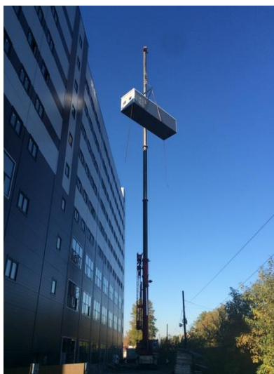
Рисунок 1.1.1 - Подъем на здание блочно-модульной котельной крышного исполнения
