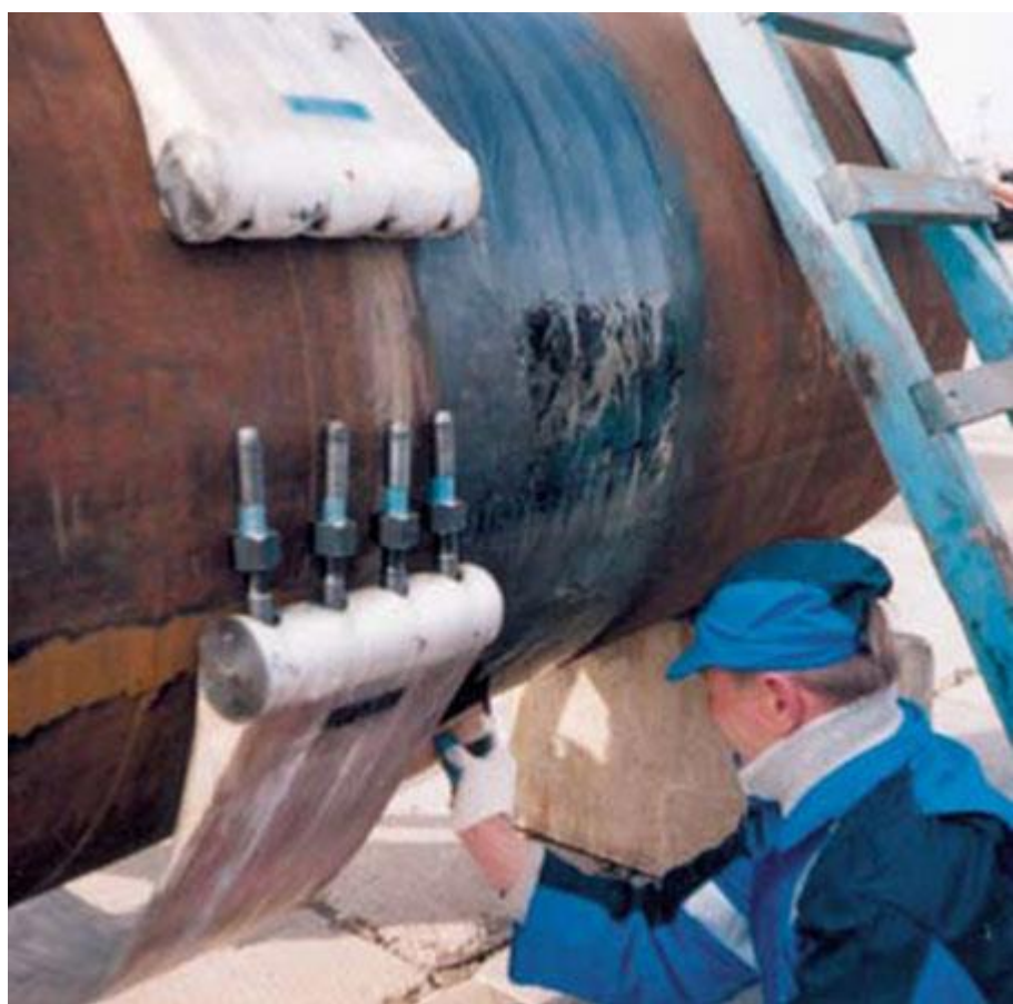
Рисунок 4.11 - Стеклопластиковая муфта РСМ-1220 в момент установки на трубу диаметром 1220 мм
