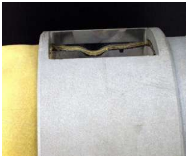
Рис.33 – Соединение с существующей трубой
