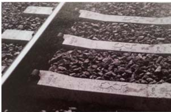
Рисунок 13 – Путь на железобетонных шпалах
