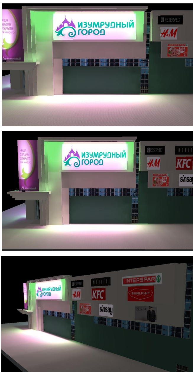
Рисунок 3.11 – Освещение ТРЦ «Изумрудный город» многоцветными светодиодными модулями со стороны Комсомольского проспекта
