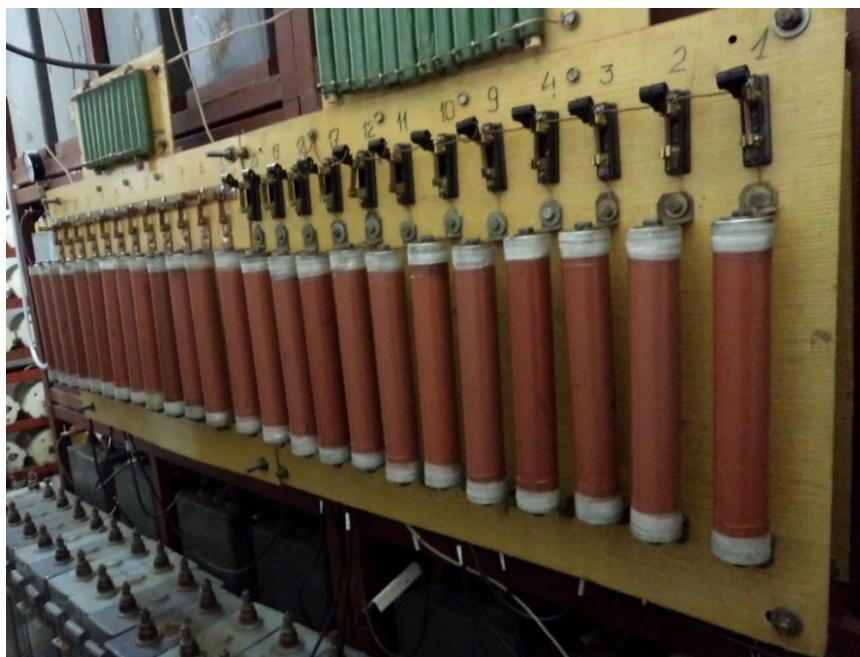
Рисунок 2.8 – Блок зарядных сопротивлений
