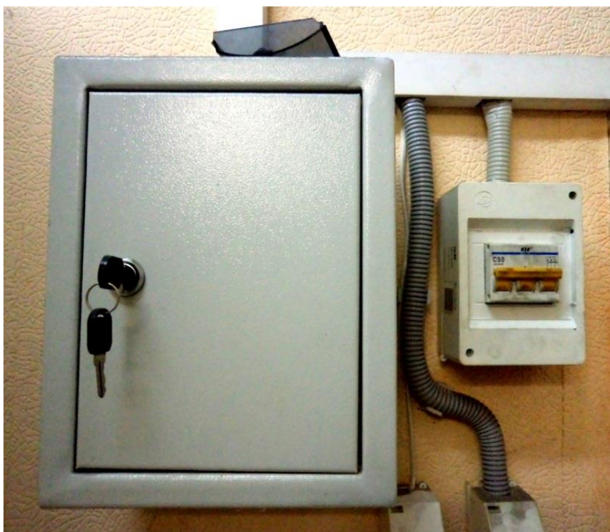
Рисунок 2.5 – Блок магнитного пускателя и автоматический выключатель
