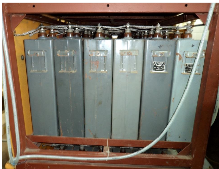
Рисунок 2.4 –Импульсный модуль конденсаторов ЕНЭ
