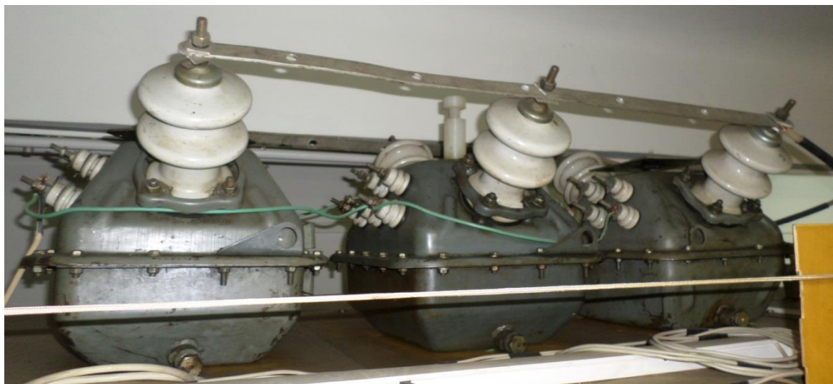
Рисунок 2.6 – Силовой трансформатор
