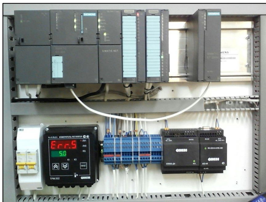
Рисунок 15 - Внешний вид смонтированного стенда для исследований ИПП размещается на пути движения объекта при помощи кронштейна (рисунок 16).
