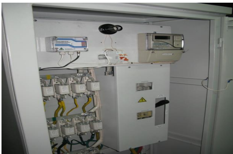
Рисунок 2.2 – Установленный прибор учета АСКУЭ
