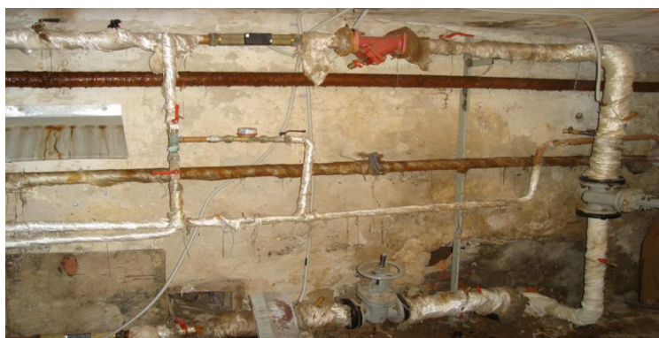
Рисунок 2.13– Материальный износ инженерных сетей ТПУ
