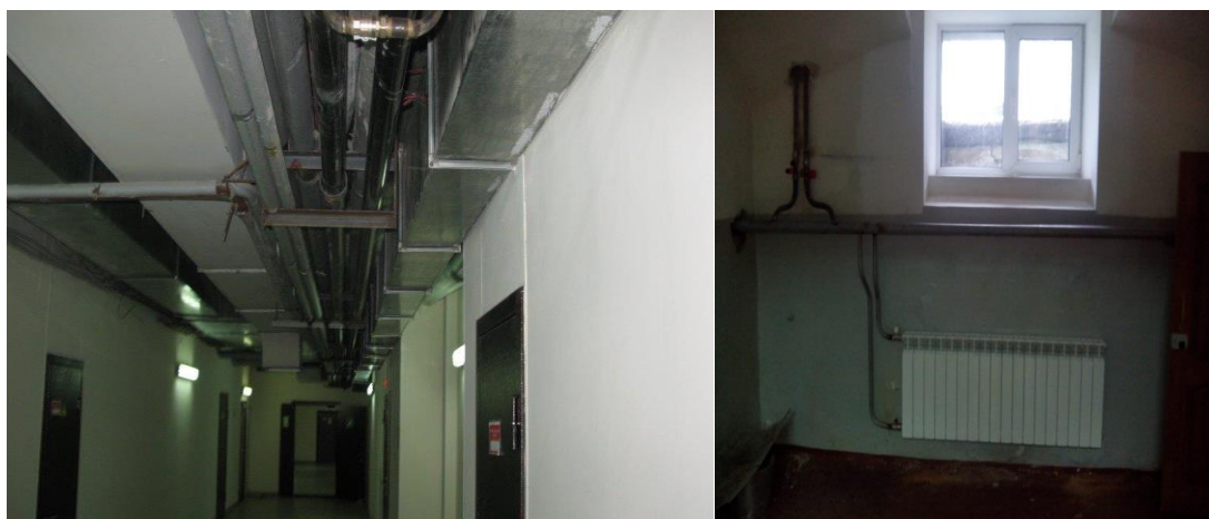
Рисунок 2.15 – Новые трубопроводы отопления и водоснабжения
