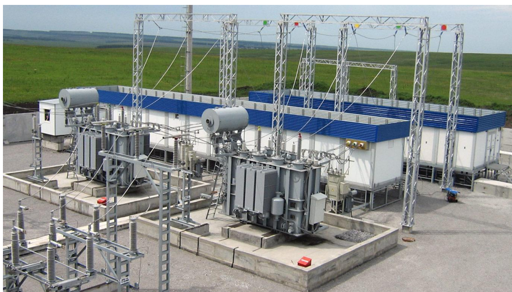
Рисунок 4.1 - КТПБ(М) 110/6 кВ
