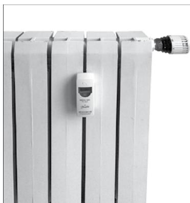
Рисунок 24 – Установка распределителя тепла на радиаторе
