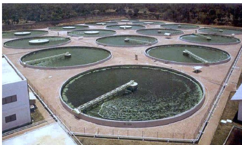
Рисунок 1.2 – Установка для выращивания хлореллы под открытым небом.
