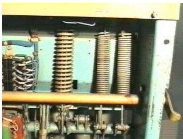
Рисунок 6.4 Рычажная система привода ВМПЭ-10
