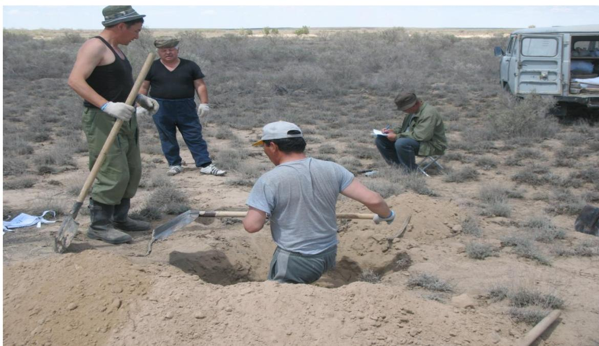
Рис.24 – Проходка шурфов
