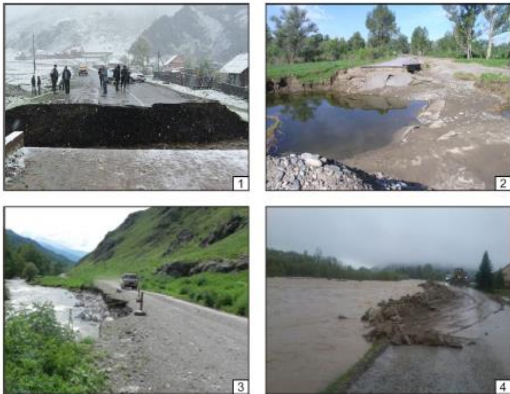
Рисунок 4.1 - Участки полного (вверху) и частичного (внизу) разрушения дорожного полотна в с. Шебалино (1), на подъездах к селам Платово (2), Эдиган (3), Каракокша (4)
