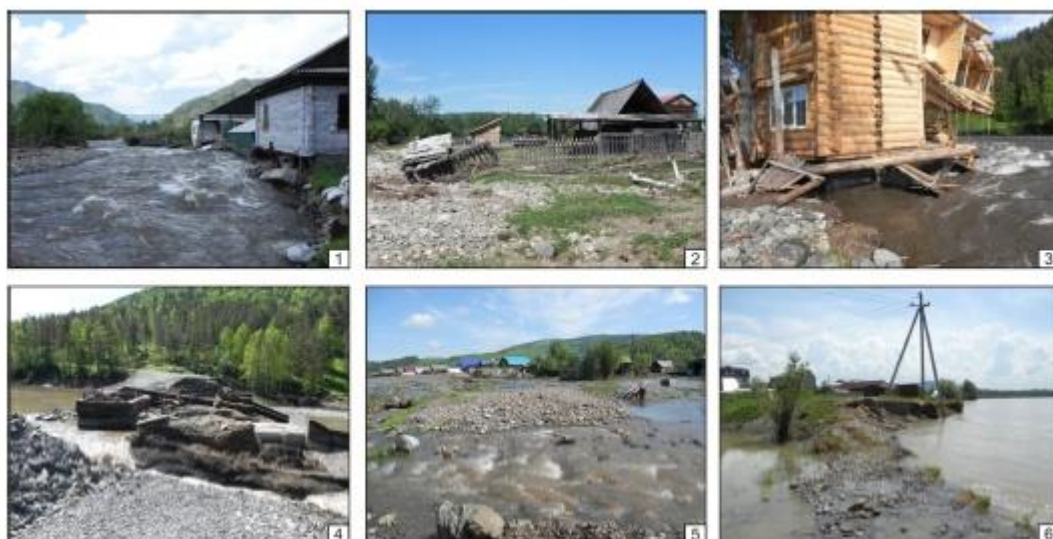
Рисунок 4.3 - Последствия паводка: частично разрушенные дома в с. Шебалино (1), надворные постройки в с. Каракокша (2), турбаза в с. Камлак (3), ГТС Куташ" (4), берегозащитная дамба в с. Кызыл-Озек (3), опора ЛЭП в Майма (4)
