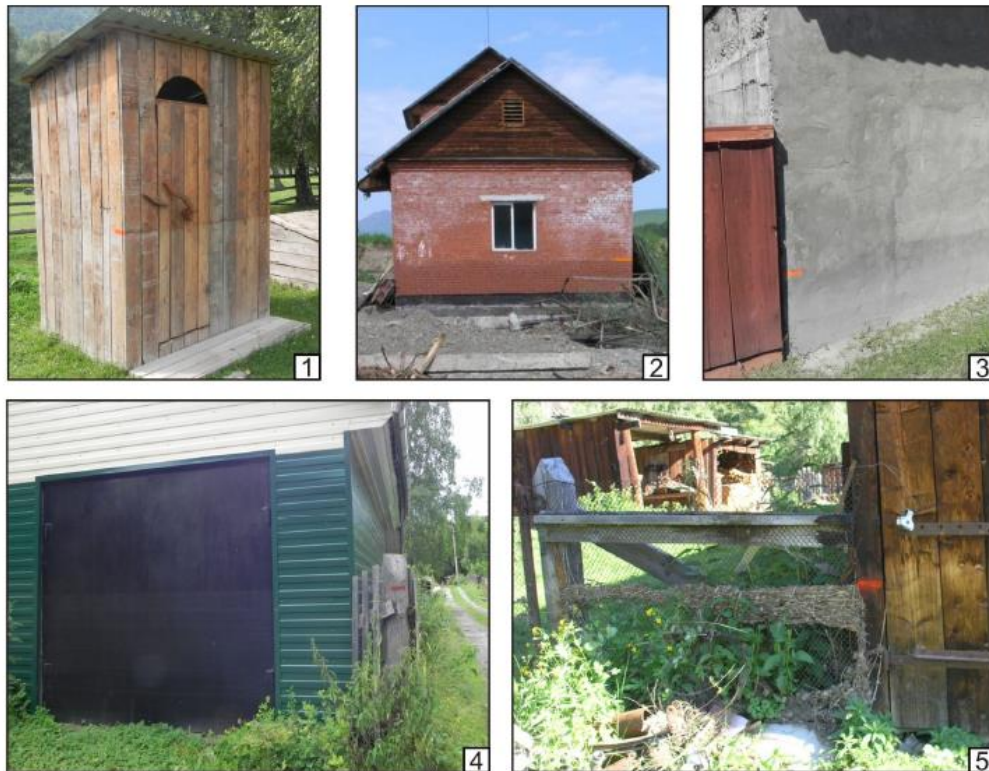
Рисунок 2.2 - Следы наивысшего уровня воды (красные метки) на деревянной (1),кирпичной (2), бетонной (3), металлической (4) поверхности и сетчатом заборе (5)
