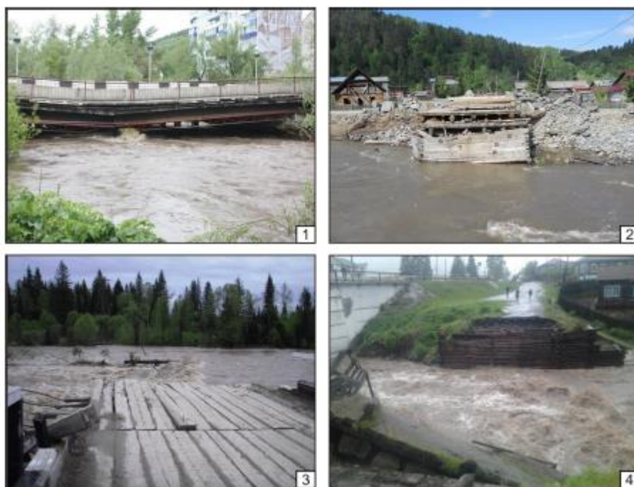
Рисунок 4.2 - Частично разрушенный автомобильный мост в г. Горно-Алтайске (1) и полностью разрушенные мосты в селах Кызыл-Озек (2), Нырга (3), Элекмонар (4)
