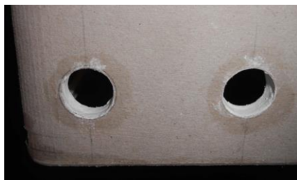
Рисунок 60. Шпаклевание отверстий
