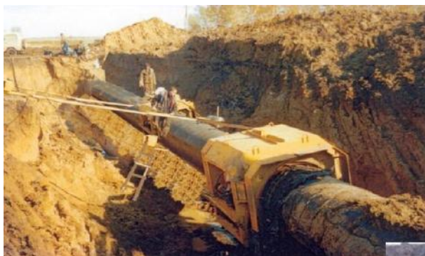
Рисунок 3.1 - Ремонт в траншее без демонтажа трубы
