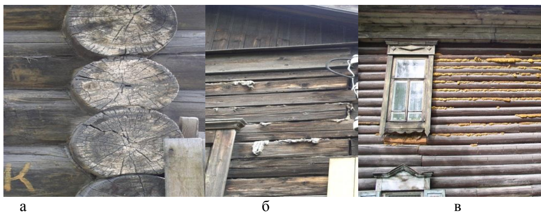
Рис. 5 Появление неплотностей в стенах между бревнами и венцами бруса, появление кольцевидных трещин.
