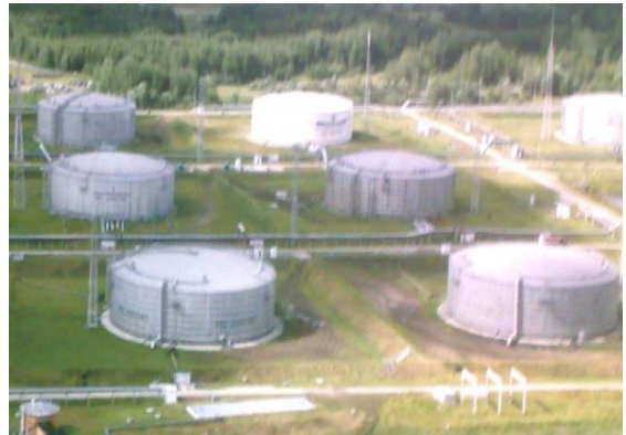
Рис. 2.1 Общий вид резервуара
