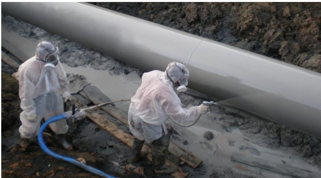
Рисунок 4.5 – Нанесение антикоррозионного покрытия Protogol UR-Coating
