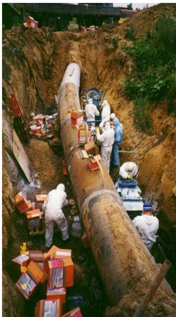
Рисунок 4.1 – Процесс монтажа КМТ
