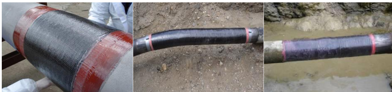
Рисунки 4.3 (а-в) – Отремонтированные участки муфтами RES-Q
